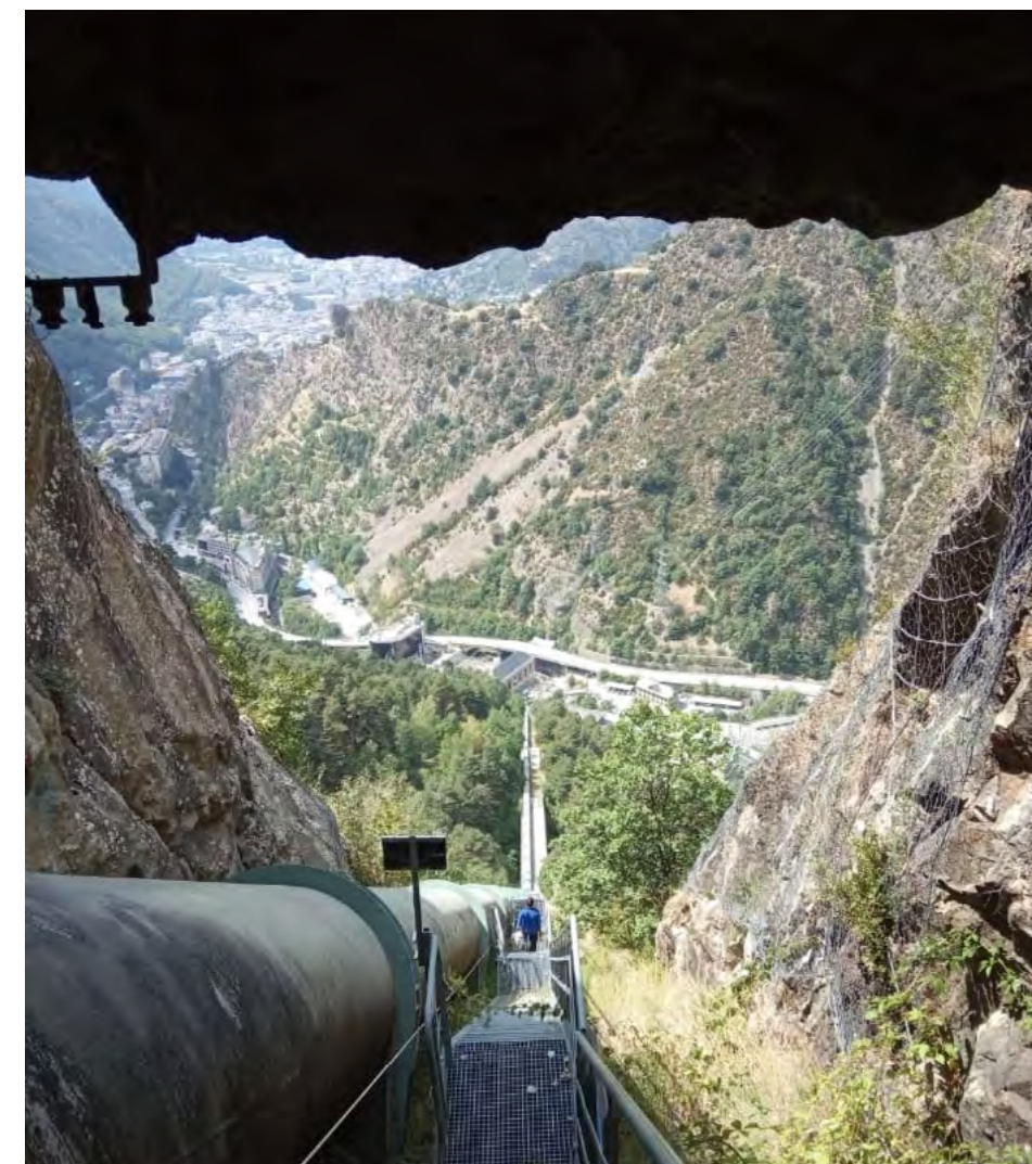
Manteniment de la canonada forçada de la Central hidroelèctrica.
